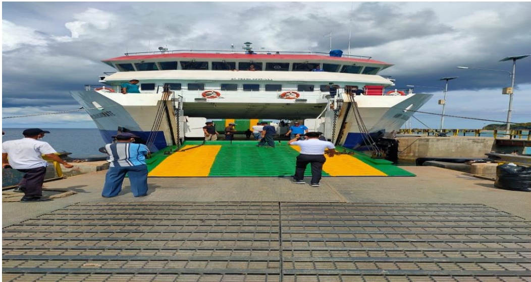
Gambar 2.1 Kapal Ferry Dengan Pintu Rampa Terbuka
