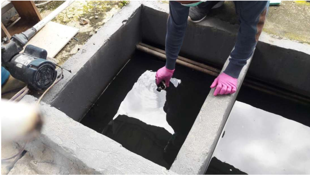
Bak Pengendapan II Limbah Rumah Sakit Sinar Kasih Toraja
