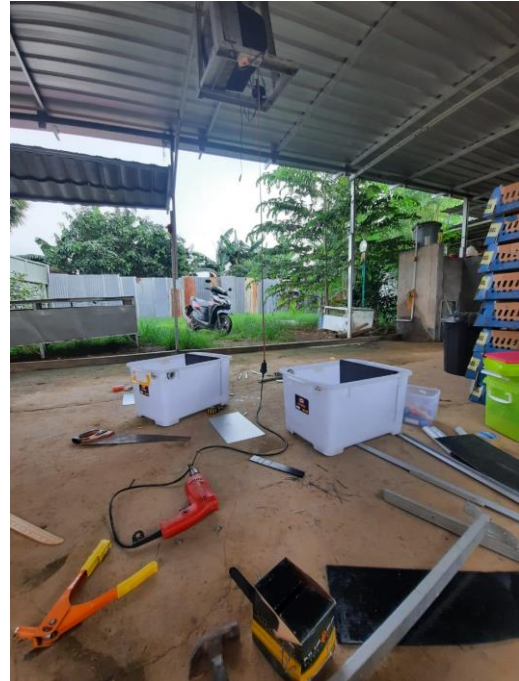
Gambar 2. Pembuatan Bak Sedimentasi
