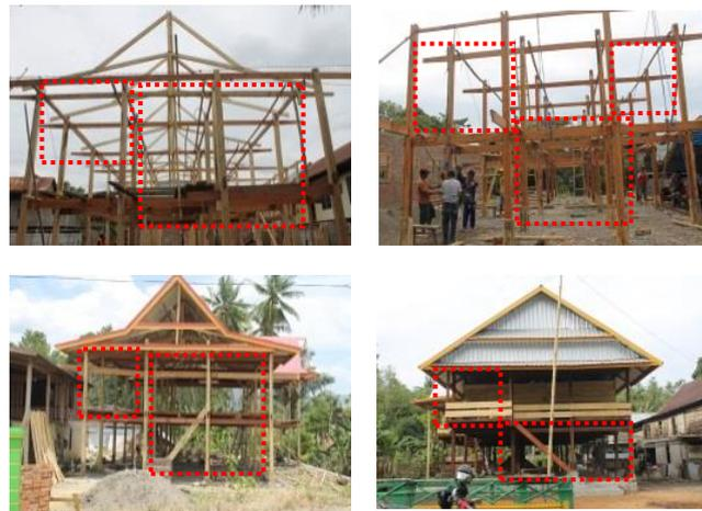
Gambar 28. Rangkaian konstruksi berbentuk persegi empat panjang (*sulapa eppa*).
