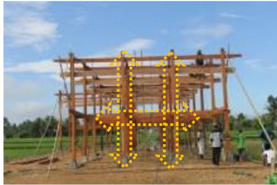
Gambar 47. Bentuk struktur dan konstruksi menyerupai huruf “H”
