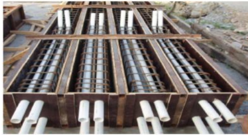
Gambar 2.21 Sambungan pracetak sistem tricon
