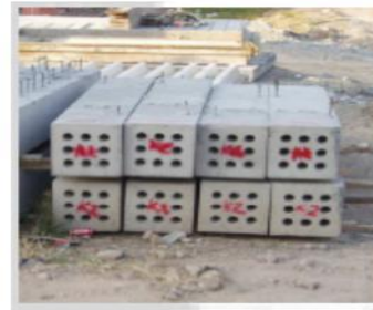
Gambar 2.21 Sambungan pracetak sistem tricon
