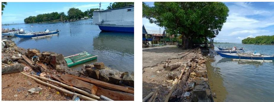
**Gambar 8.** Konstruksi penahan tanah yang cenderung terlepas dari ikatan pasangan specie
