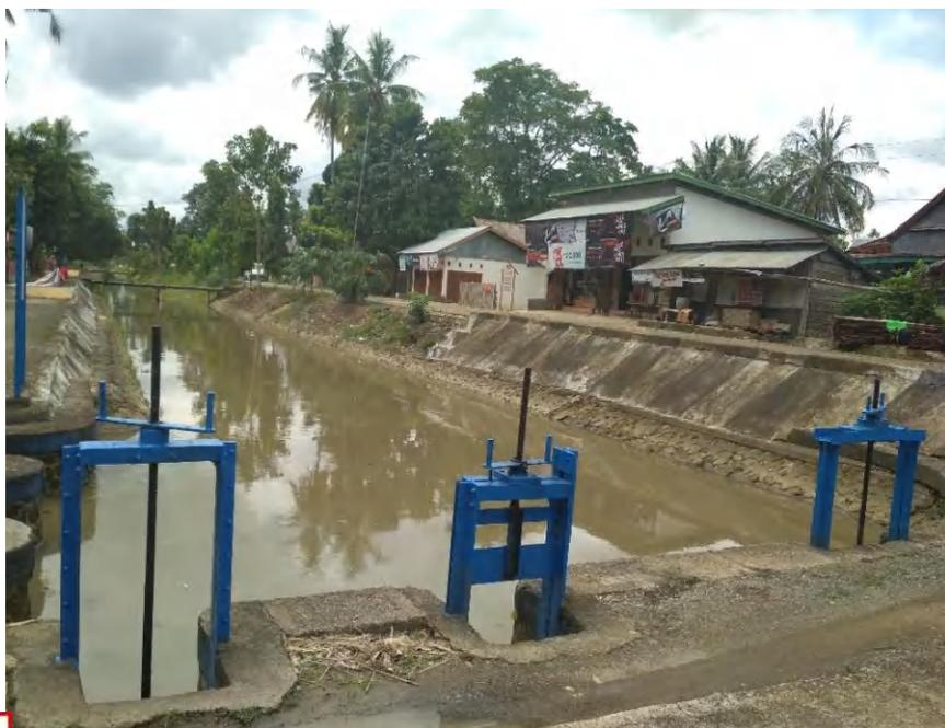
**Gambar 2. Pintu Operasi Saluran Sekunder DI Taccipi**
