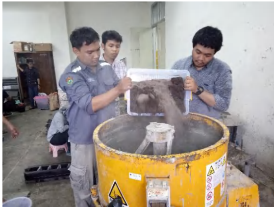
Proses pencampuran material di dalam mesin mixer.
