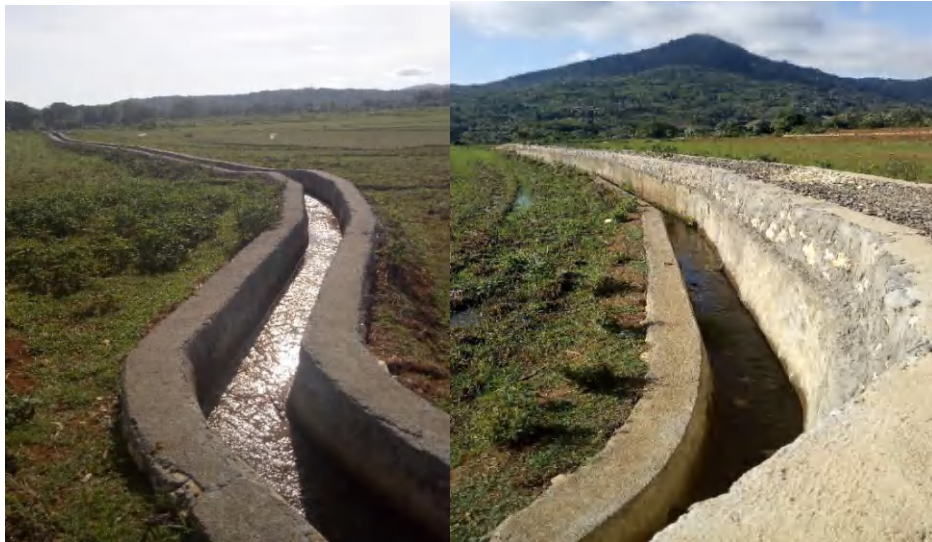
Gambar 2. Saluran irigasi tersier
