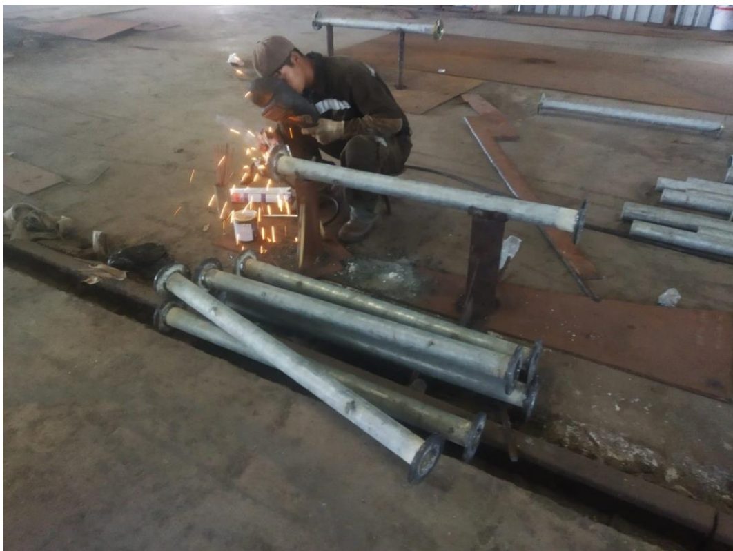
Lampiran 16 Proses fabrikasi sistem instalasi pipa
