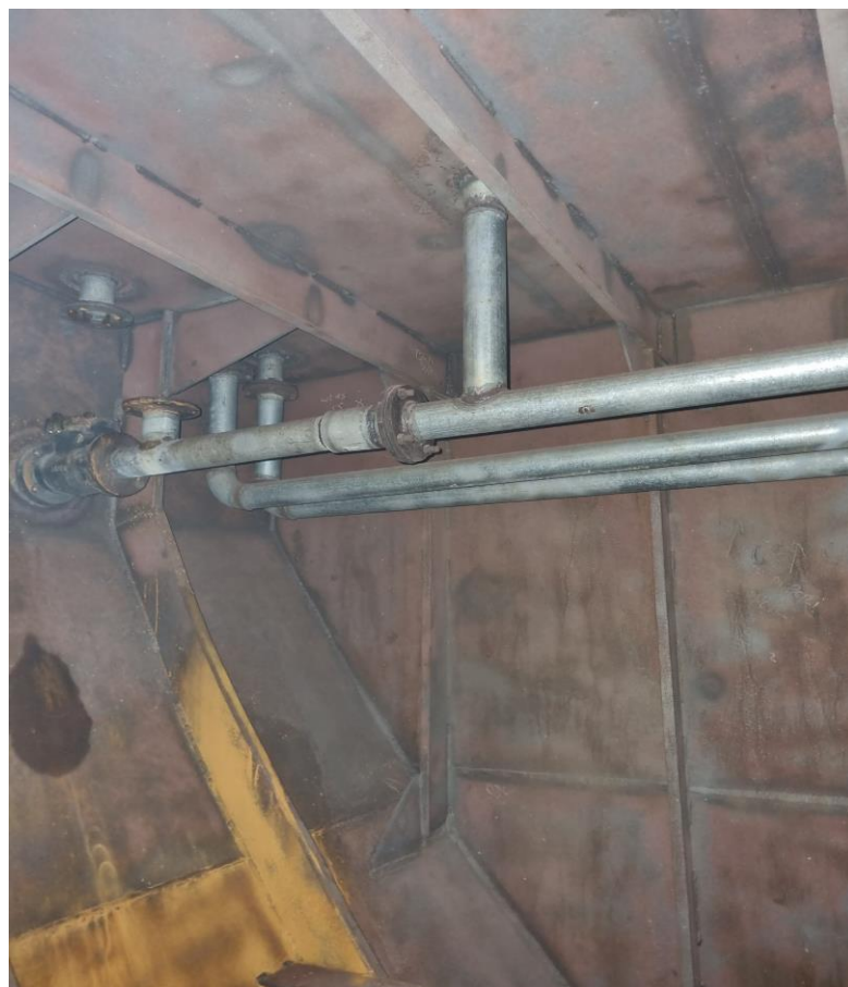
Lampiran 21 Pemasangan instalasi pipa
