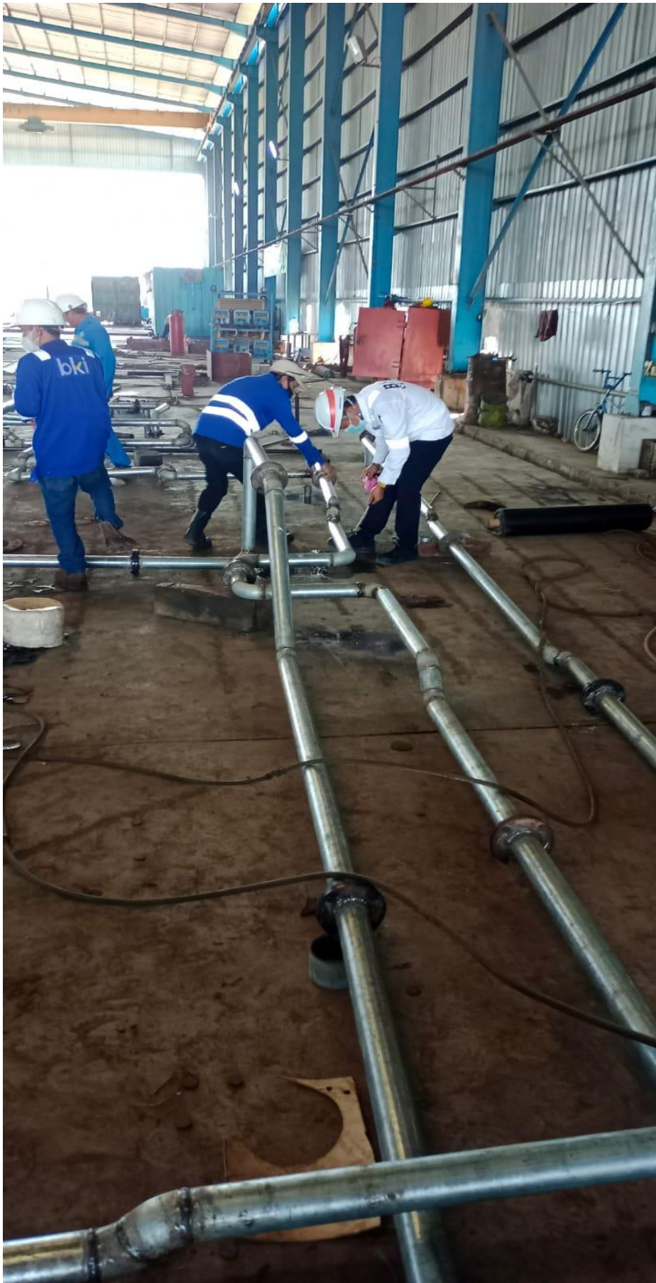
Lampiran 19 Pengetesan uji kebocoran instalasi pipa
