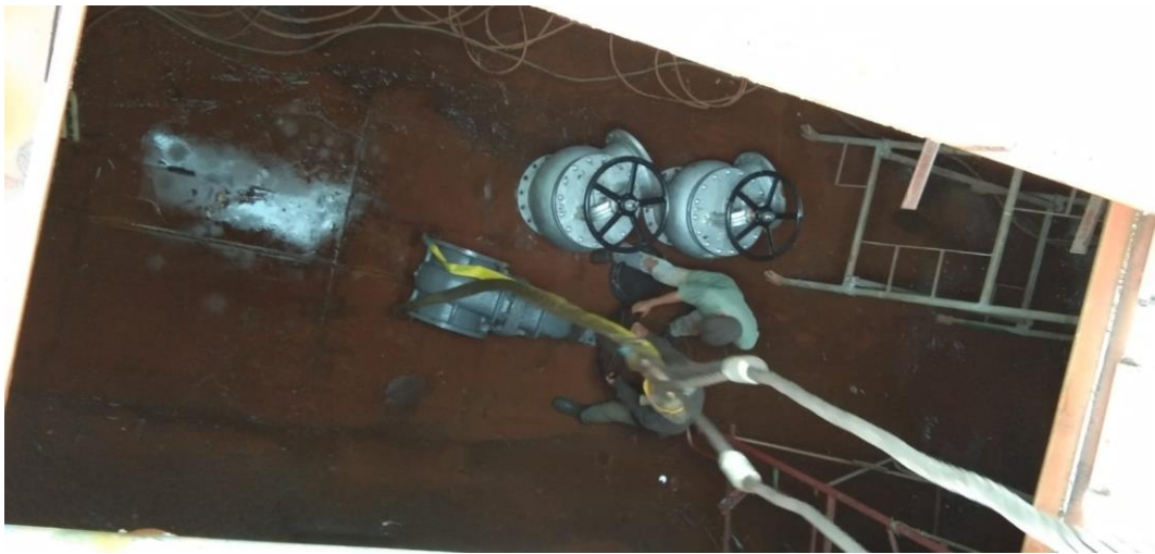
Lampiran 18 Pemasangan valve pada pipa induk
