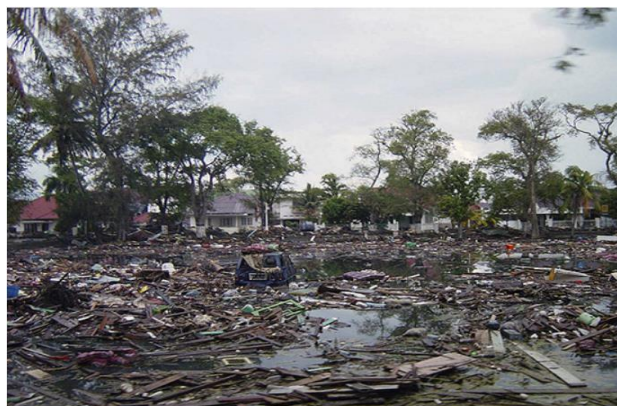
Gambar 2.4 Sampah dan puing-puing menutupi jalan-jalan di Banda Aceh, Indonesia, setelah tsunami tahun 2004 (Sumber: Michael L. Bak, 2007)
