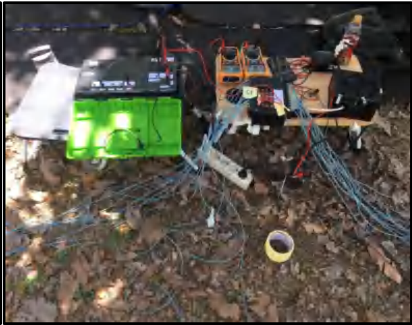
Persiapan Pemasangan Alat pada Pengukuran Lapangan
