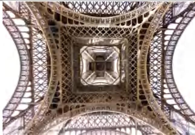
**Gambar 8** Truss dalam truss dalam struktur Hierarki Menara Eiffel
