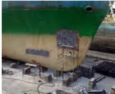
Gambar 4 Penggantian plat lambung kapal
