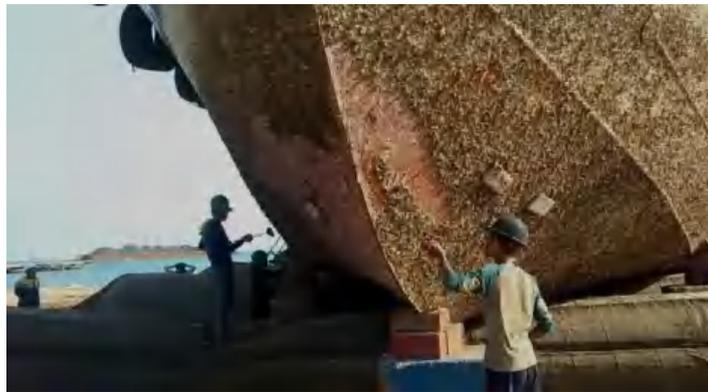
Gambar 20. Proses penyekrapan
