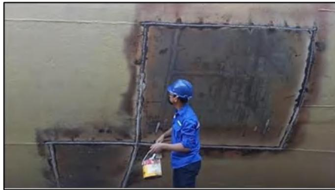
Gambar 2.13 *Welding check* menggunakan kapur dan solar
