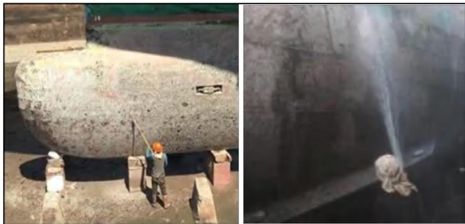
Gambar 2.1 Penyekrapan dan Water Blasting
