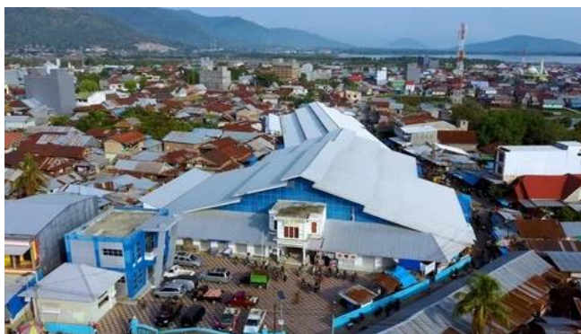
Gambar 1. Bangunan Pasar Andi Tadda Kota Palopo
