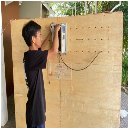
Pemasangan Alat Kontrol pada Kumbung Jamur.
