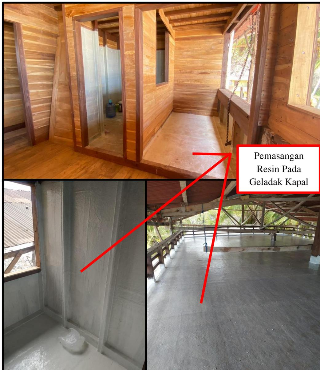
Gambar. 17 Contoh Hasil Pemasangan *Glass fiber* pada geladak kapal
