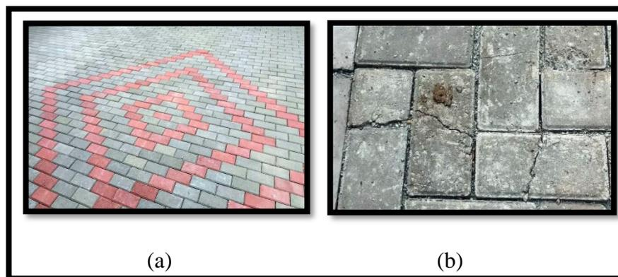
Gambar 10 (a) Gambar *Paving Block* (b) Gambar Keretakan pada *Paving Block*
