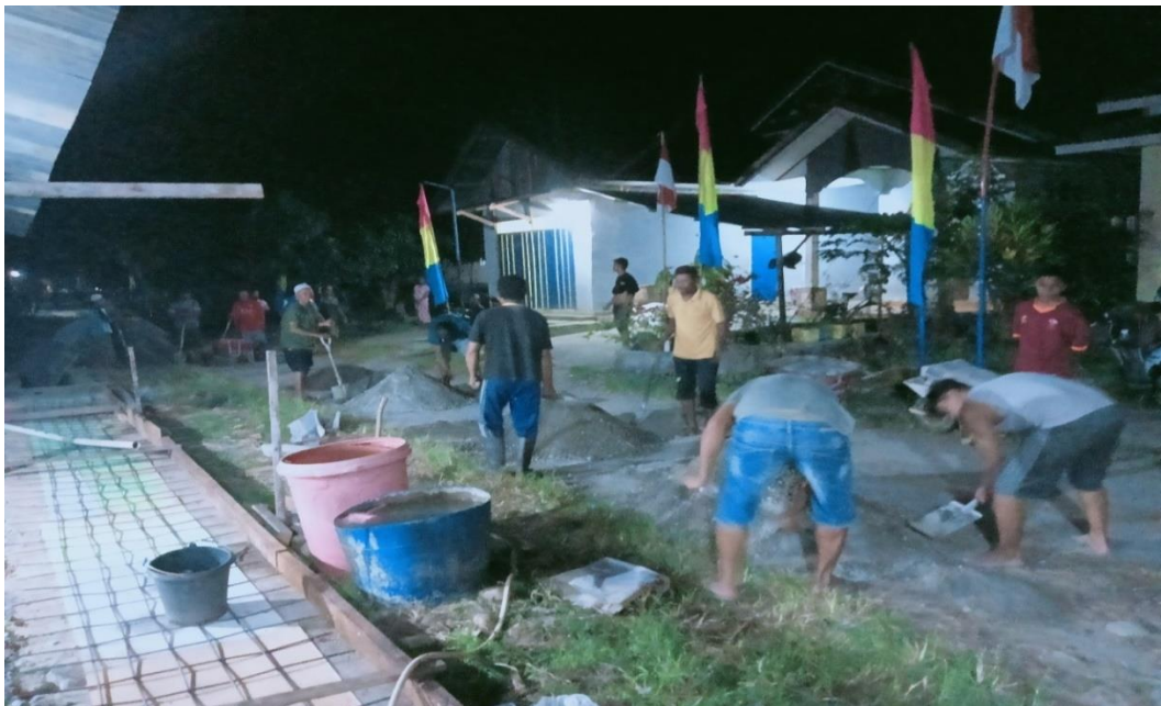
Gambar 4 : Sambatan Mengecor Teras Rumah.
