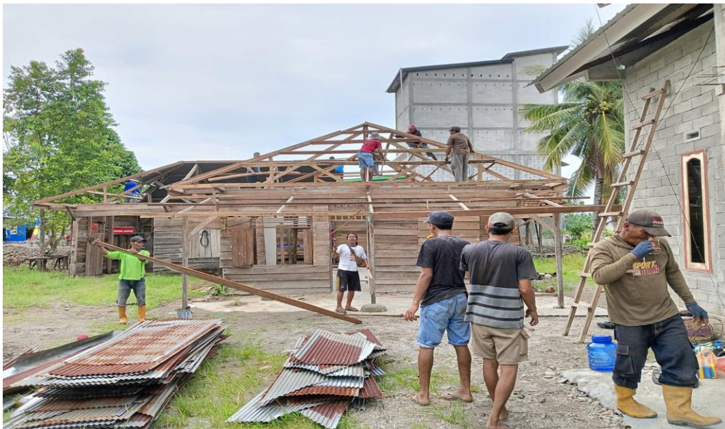
Gambar 8 : Sambatan Memperbaiki Atap Rumah.
