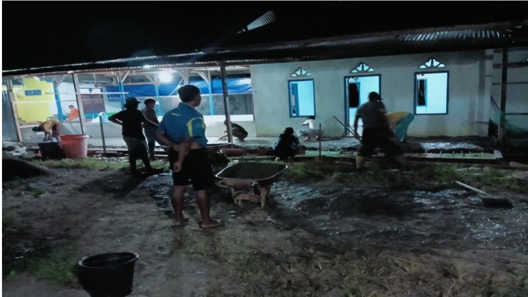
Gambar 5 : Sambatan Mengecor Teras Rumah.
