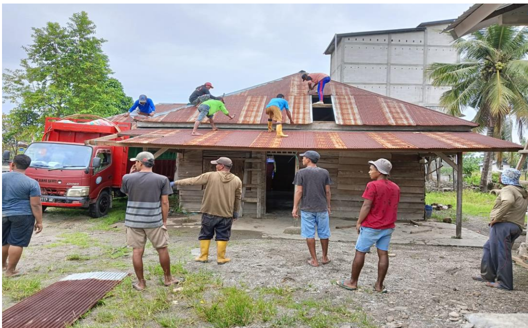
Gambar 9 : Proses Pemasangan Atap Rumah.
