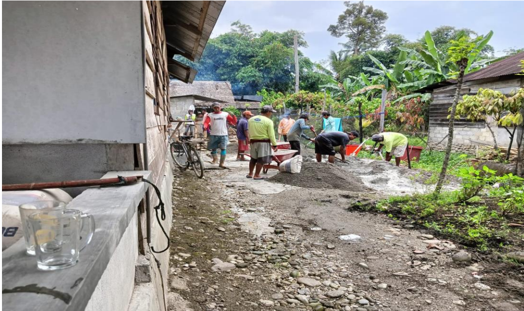
Gambar 7 : Sambatan Membuat Pondasi Rumah.
