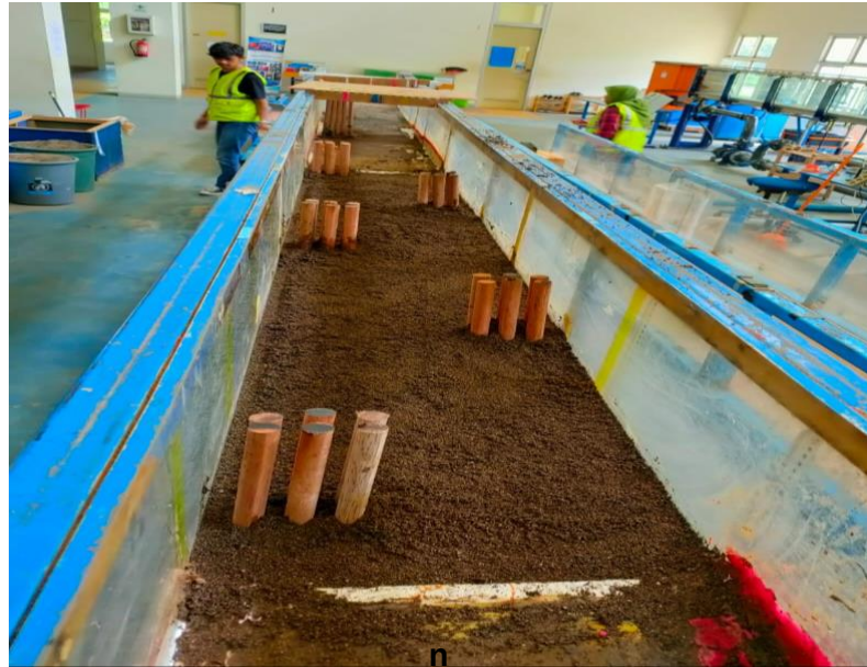
Gambar 31. Pemasangan model krib permeable
