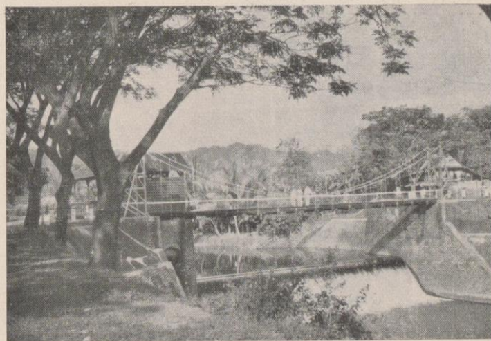
Brug over irrigatiewerken Bantimoeroeng
