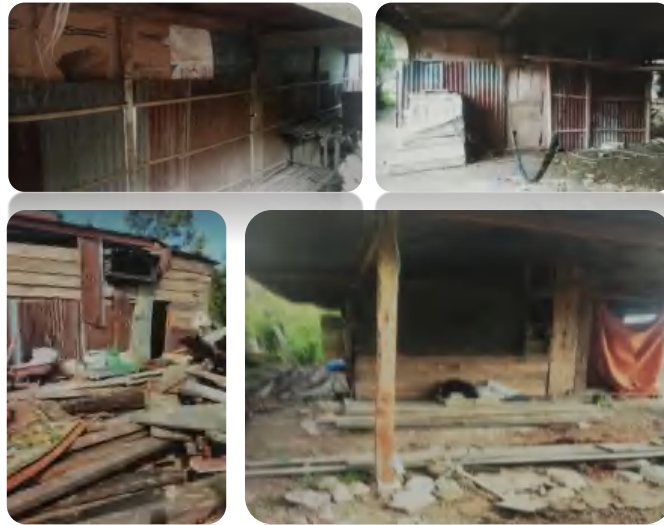
Foto kondisi rumah sebelum pembangun RLH BAZNAS Kabupaten Enrekang Sumber: BAZNAS Kabupaten Enrekang,2023
