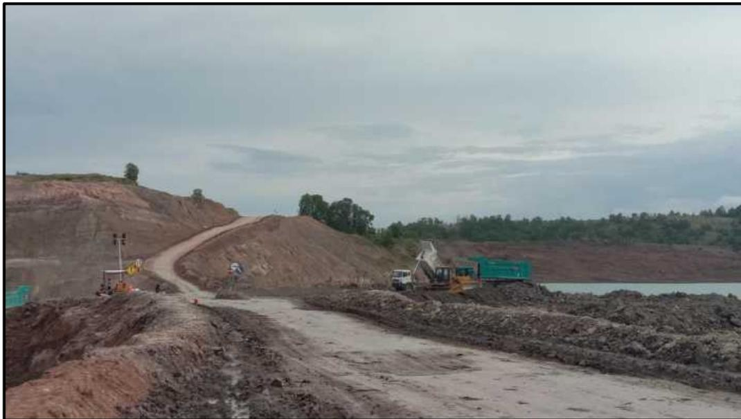
Gambar 5 Proses Penimbunan Material *Overburden* pada *In pit Dump*
