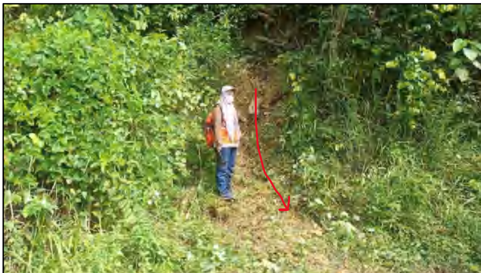
Gambar 14 Kenampakan Debris Slide pada litologi Batupasir Karbonatan pada stasiun 12 difoto pada arah N 183°E
