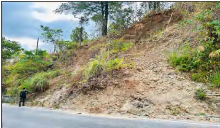
Gambar 11 Kenampakan *debris slide* pada stasiun 52 daerah malino dengan arah foto N183<sup>0</sup>E
