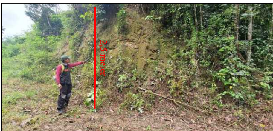
Foto 2.15 Kenampakan residual soil pada litologi batugamping yang dijumpai pada stasiun 54 Daerah Samaenre dengan arah foto N 51° E
