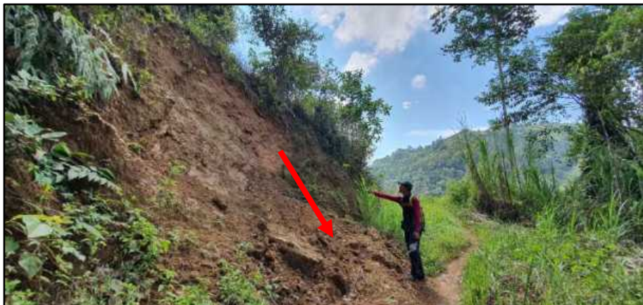
Foto 2.14 Kenampakan gerakan tanah berupa debris slide , soil dan fragmen batuan bergerak turun pada sekitar Stasiun 46 Daerah Patanyamang dengan arah foto N 29° E
