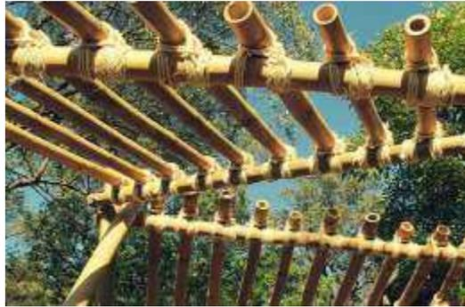
Gambar 9 Sambungan bambu dengan tali
