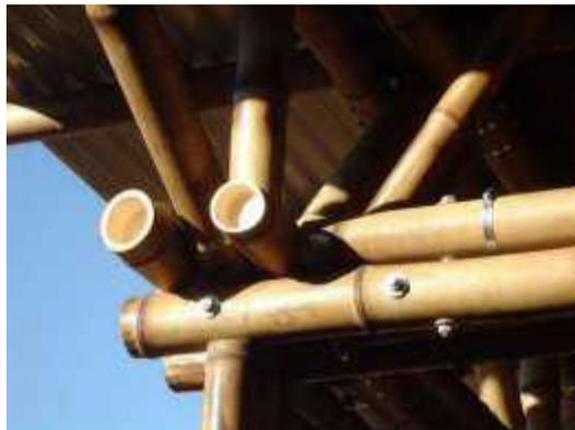
Gambar 10 Sambungan bambu dengan mur-baut
