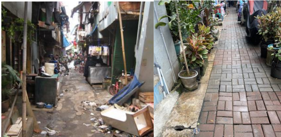
Gambar 14. Kualitas jalan sebelum dan setelah perbaikan
