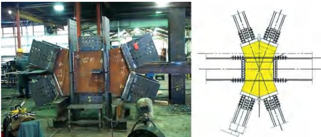
Gambar 8. Node atau sambungan pada struktur diagrid
