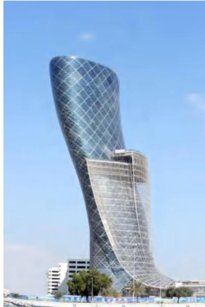
**Gambar 3.** Penerapan modul kecil struktur diagrid pada Capital Gate, Abu Dhabi
