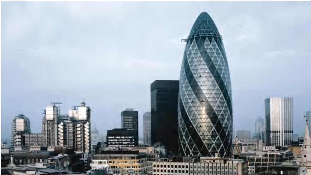
Gambar 2. Penerapan Struktur Diagrid pada 30 St. Mary Axe di London
