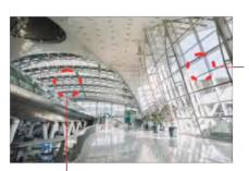
Struktur tengah bangunan menggunakan rangka baja dengan material dinding kaca (glass wall) dan bebas kolom agar mempermudah sirkulasi dan pandangan ke segala arah
