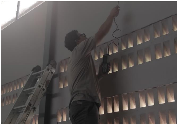
Pengukuran pada Bagian Belakang Atas Lapangan Indoor
