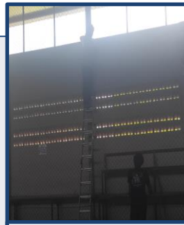
Pengukuran pada Bagian Belakang Bawah Lapangan Indoor
