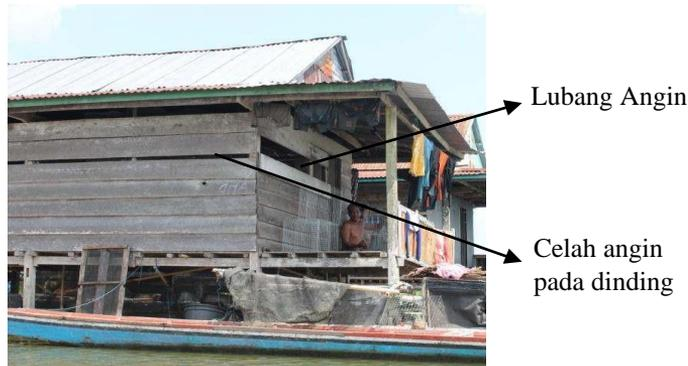
Gambar 11 Struktur dinding kayu pada rumah mengapung
