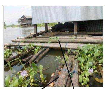
Gambar 4 Struktur lapisan bambu pada rakit di umah mengapung
