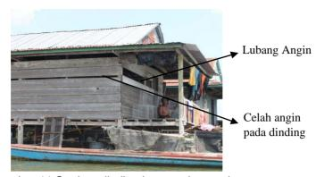
Gambar 11 Struktur dinding kayu pada rumah mengapung
