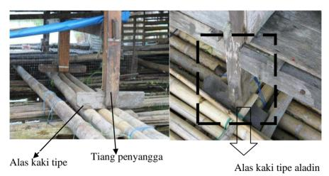
Gambar 7 Detail struktur tiang bawah dengan alas kaki tipe Aladin
