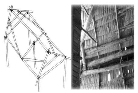
Gambar 21 Konstruksi atap Suku Bajo
