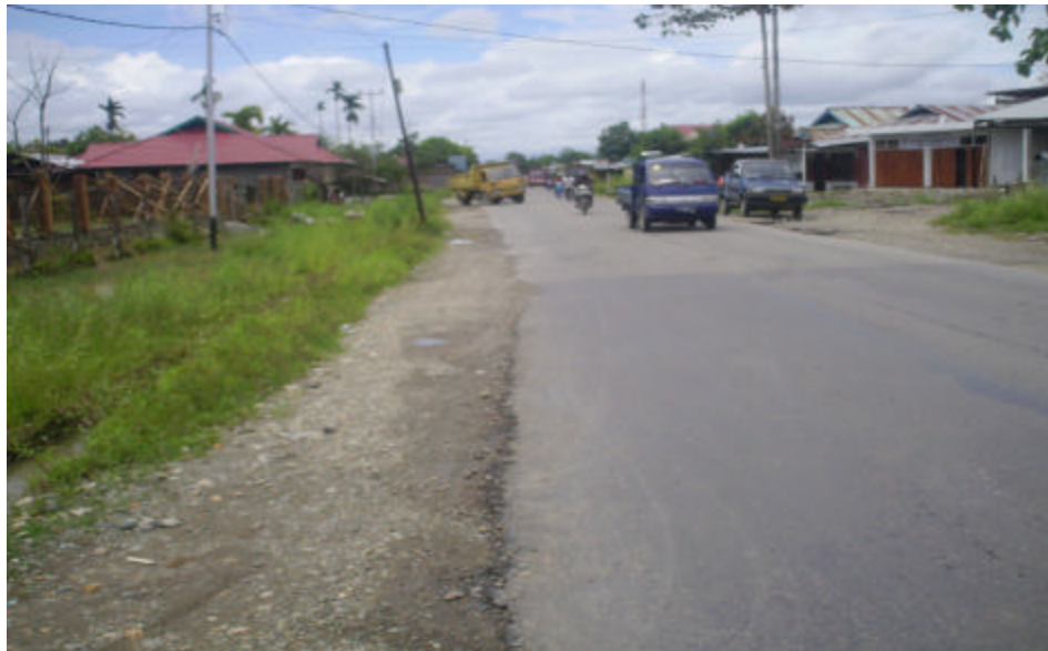
Gambar 9. Kondisi Jalan Yos Sudarso (Segmen C)
