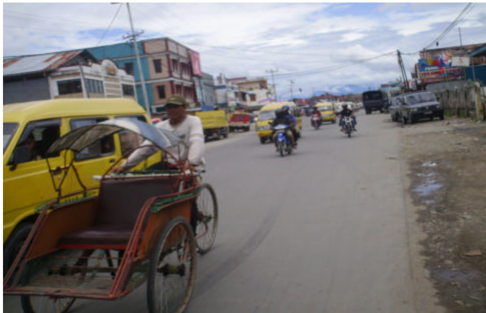
Gambar 7. Kondisi Jalan Yos Sudarso (Segmen A)
