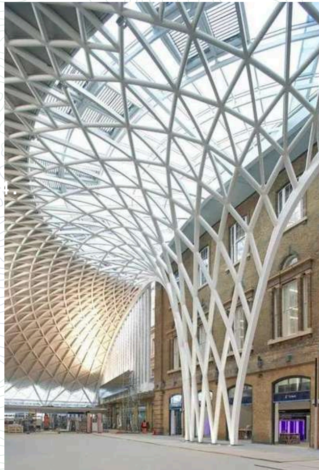
struktur rangka truss
