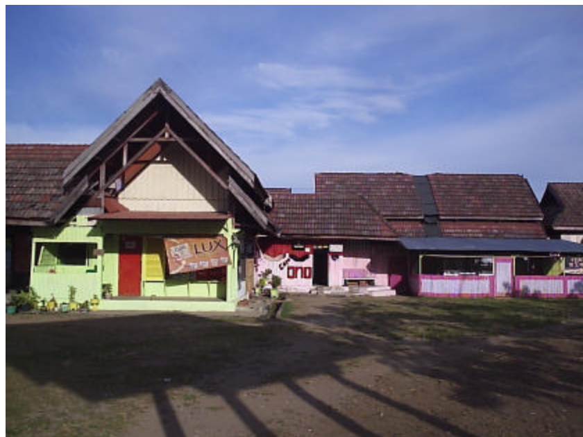
Ket. Gambar : Gedung Pasar Seni, salah satu tempat prostitusi di Kota Parepare. Suasana Pasar Seni pada siang hari. Tampak bangunan Pasar Seni yang disulap menjadi tempat bar dan kafe.
