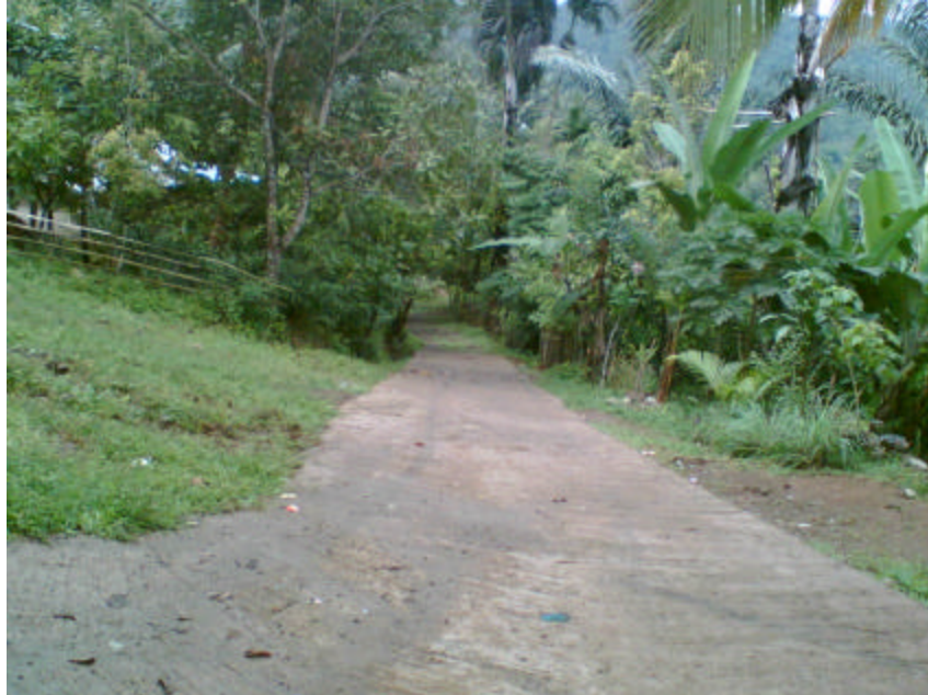
Prasarana Jalan di Talise Desa Saotengga pelaksanaan TA. 2003
