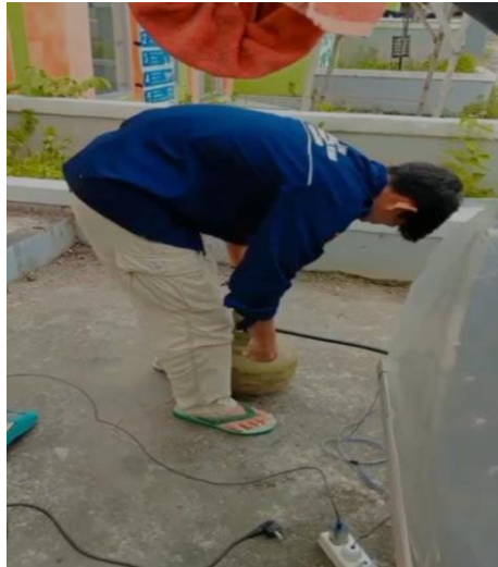
Gambar 9. Proses Pemasangan Gas.
