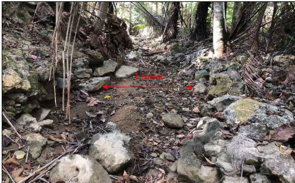
Gambar 13 Kenampakan gully erosion pada stasiun 36 dengan arah foto N 193°E
