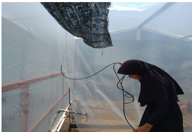
b. Pemasangan instalasi irigasi kabut dan irigasi tetes
