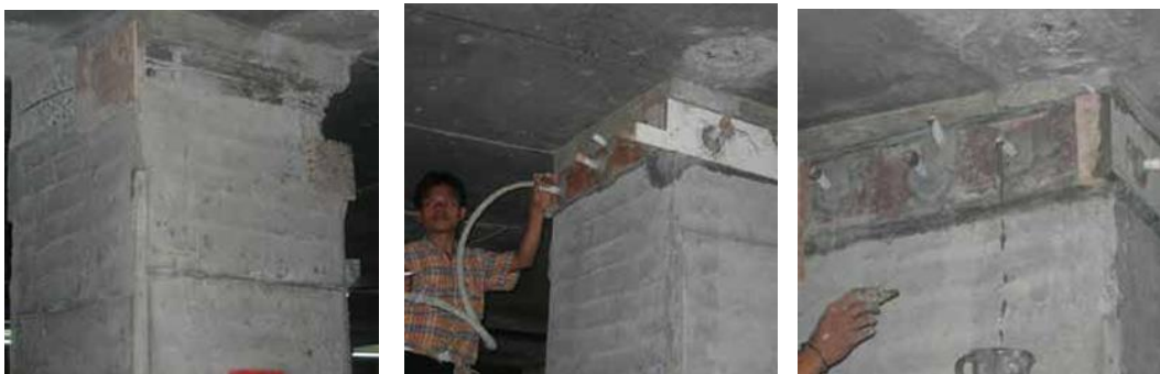
Gambar 7. Grouting dengan metode injeksi
