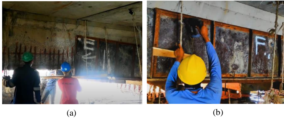
Gambar 11. (a) Pemasangan bekisting pada struktur balok, (b) Pengencangan baut pada sambungan bekisting balok
