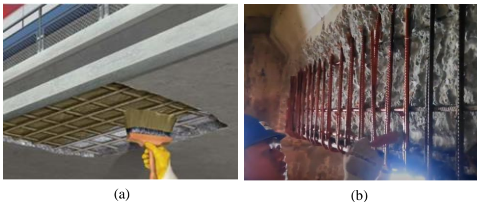
Gambar 10. (a) Pemberian lapisan anti karat pada tulangan pelat, (b) Pemberian lapisan anti karat pada tulangan balok
