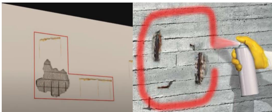
Gambar 8. Marking area perbaikan pada beton bertulang yang mengalami kerusakan
