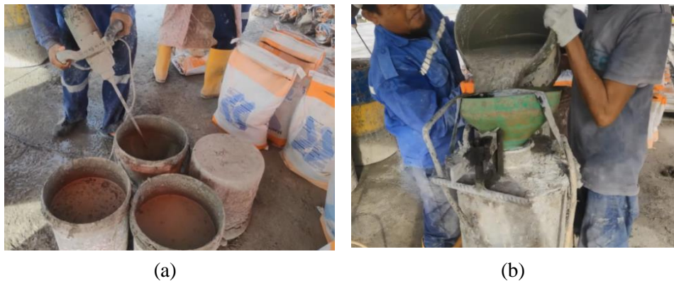
Gambar 12. (a) Pencampuran material grouting , (b) Penuangan material grouting pada alat injeksi
