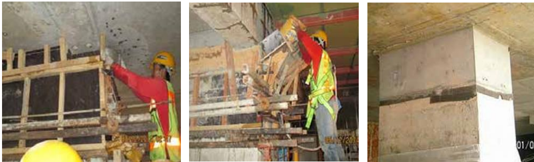
Gambar 6. Grouting dengan metode tuang
