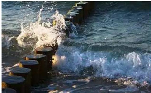
Gambar 4. Pemecah gelombang sambung pantai
