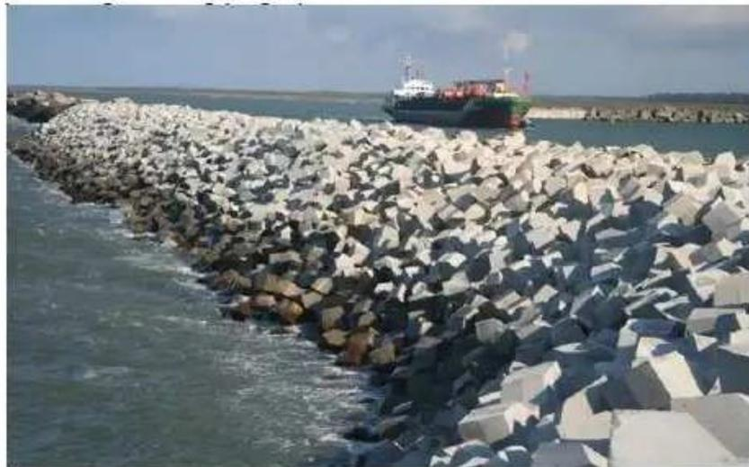
Gambar 5. Pemecah gelombang kubus beton tumpuk untuk melindungi kapal dari gelombang
