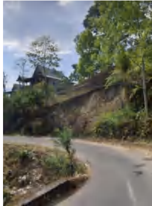
(a) Lokasi kejadian longsor TL1 pada tahun 2023
