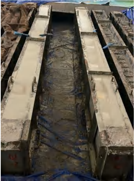
Beton setelah pengecoran Mortar Grouting
