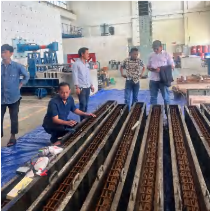
Pemasangan SG Baja Tulangan
