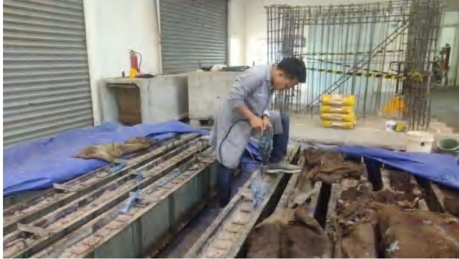
Pembuatan lubang Angkur Dynabolt
