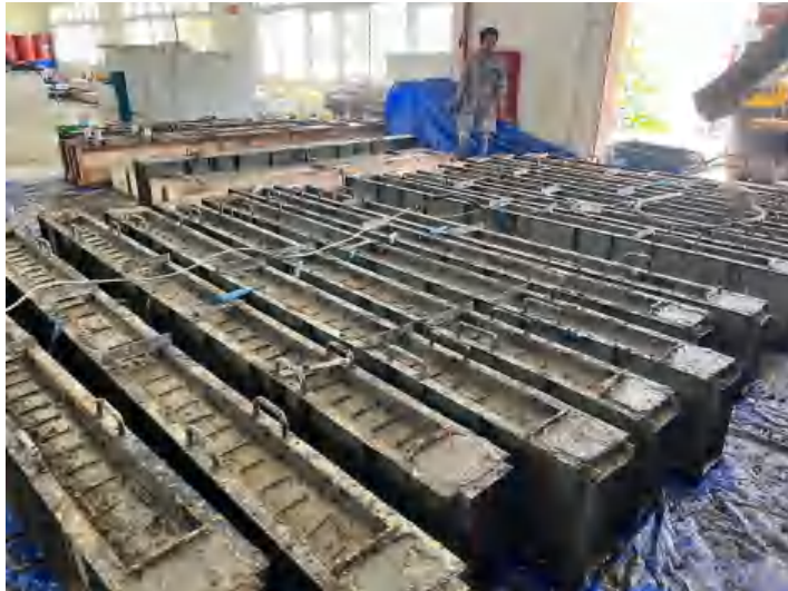
Hasil akhir pengecoran Balok
