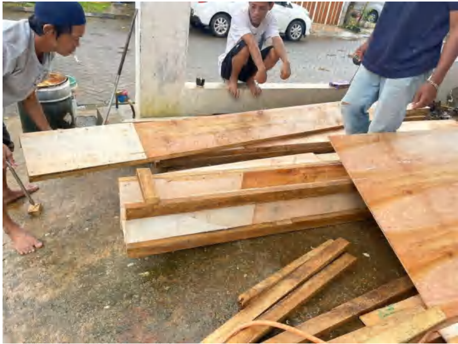
Pembuatan bekisting balok
