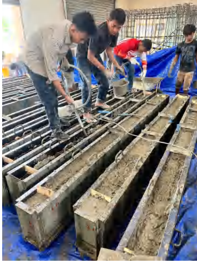
Pemadatan Beton dengan Vibrator
