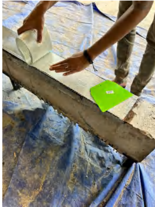
Pemasangan Lembaran GFRP
