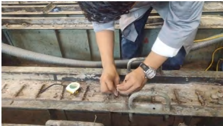
Pemasangan Angkur Dynabolt
