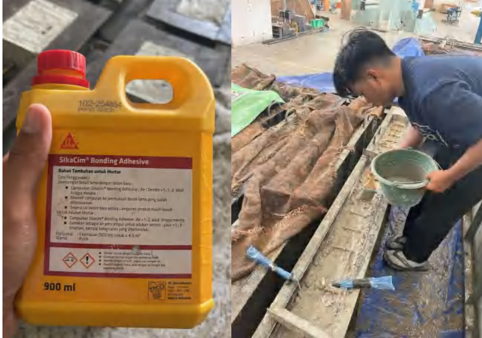
Aplikasi Sika Bond sebelum penuangan Mortar Grouting
