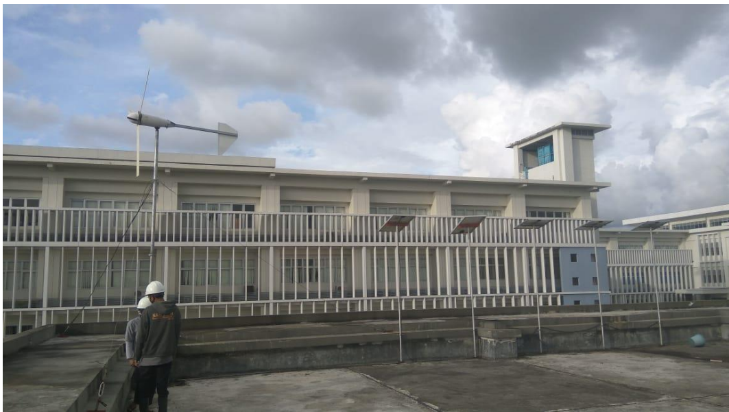
Panel surya yang terpasang pada rooftop Laboratorium Teknik Tegangan Tinggi dan Infrastruktur Ketenagalistrikan Fakultas Teknik Universitas Hasanuddin
