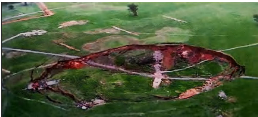
Gambar 6 Amblesan yang terjadi di Ridgeway, New South Wales (Rolinator, 2006., dalam Geoteknik Tambang).
