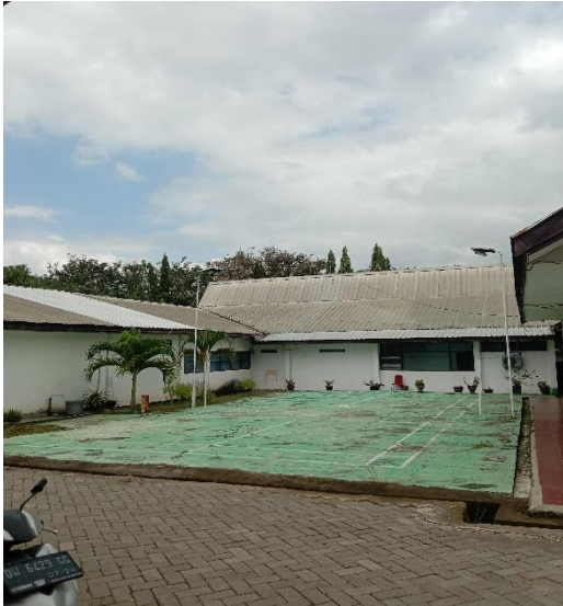
Lapangan lokasi kantor.
