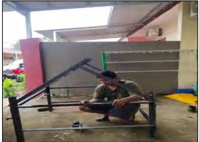
Pengecatan rak dengan anti karat
