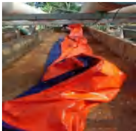
Gambar 3. Pemasangan terpal
